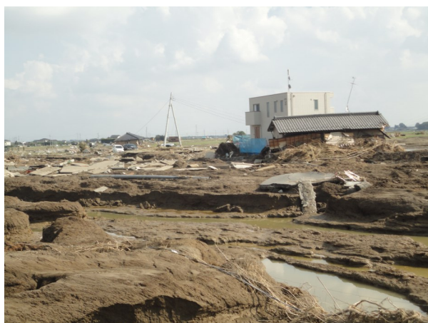
水害直後の状況
